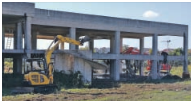
La struttura in cemento che sarà completamente demolita
